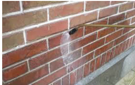
hydrofoberen van metselwerk
