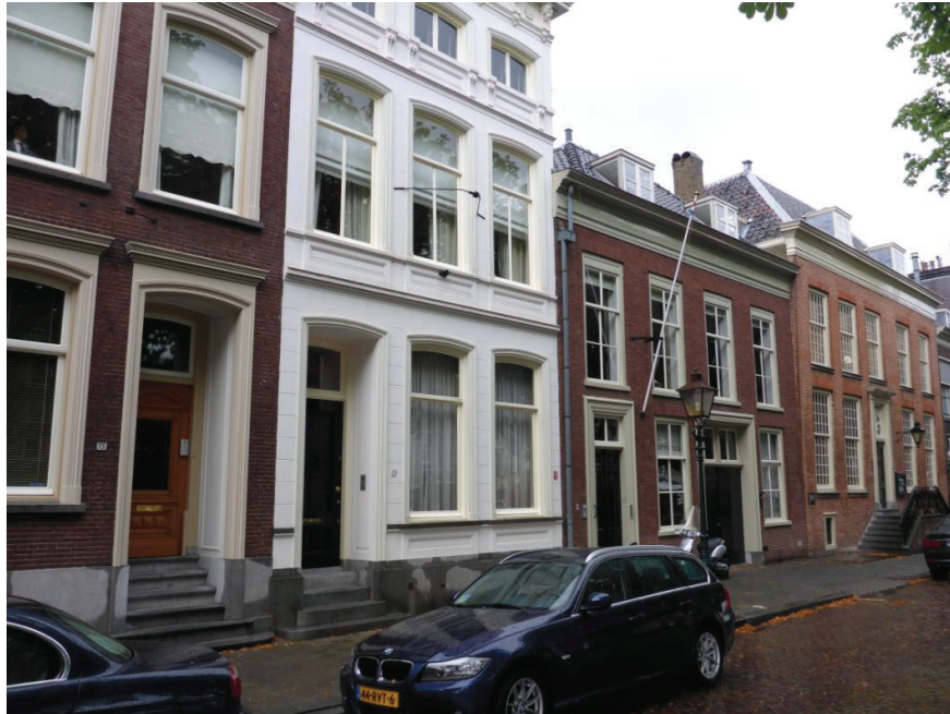
Detailfoto 1: de voorgevel
