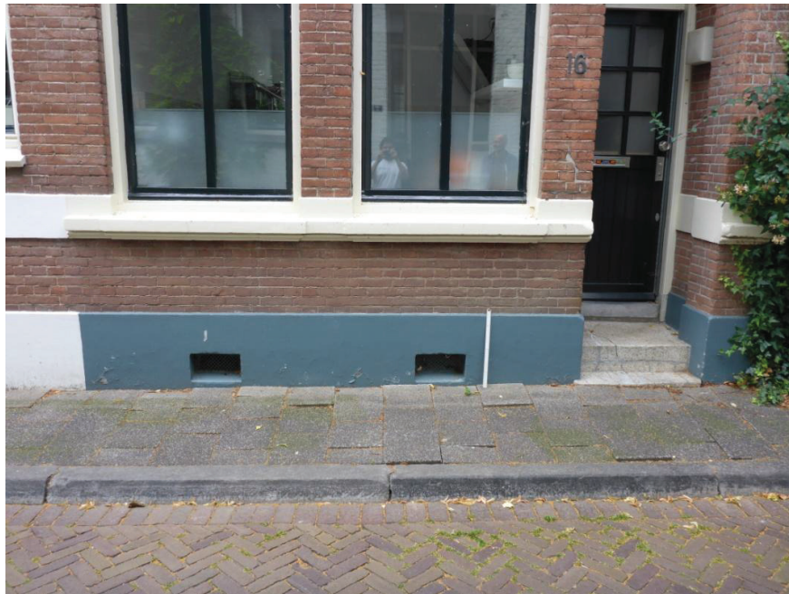
Detailfoto 3: kruipruimte-ventilatie in de voorgevel
