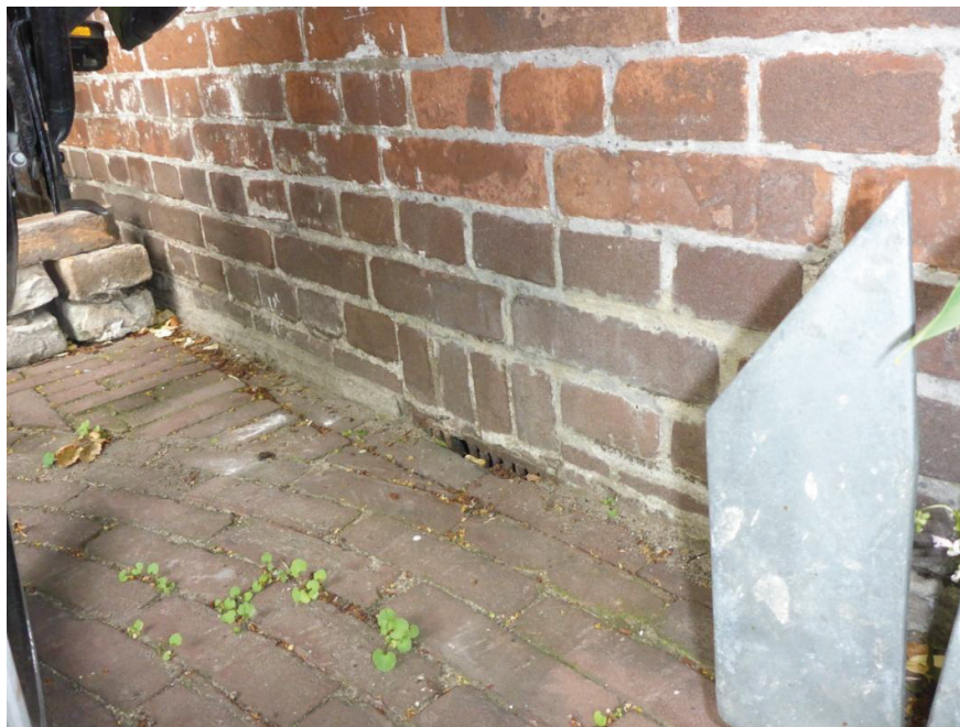
Detailfoto 2: kruipruimte-ventilatie in de zijgevel
