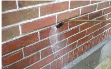
hydrofoberen van metselwerk
