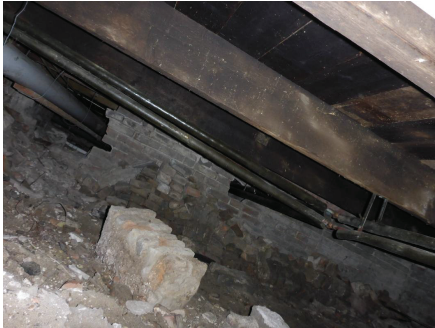
Detailfoto 5: houten vloerconstructie
