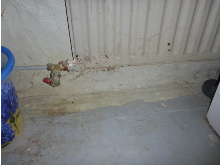
Detailfoto 5: de keldermuur aan de achterzijde van het pand is waterdicht gemaakt.
