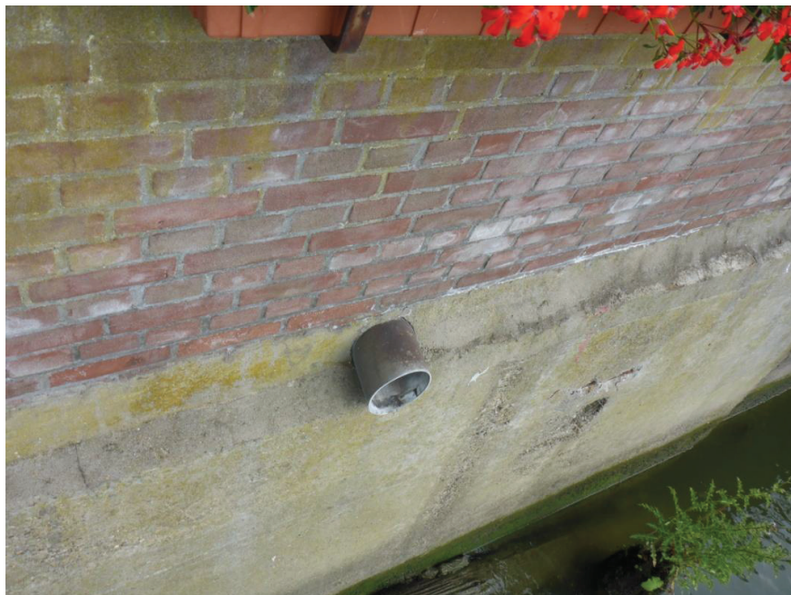
Detailfoto 4: kruipruimte-ventilatiepijp door de kademuur
