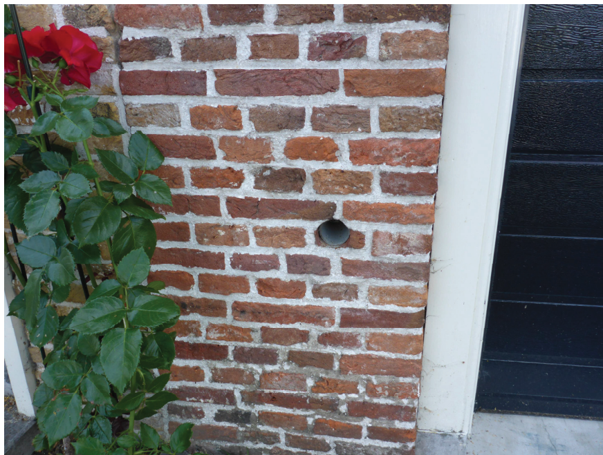
Detailfoto 8: Leidingdoorvoer voor pomp.
