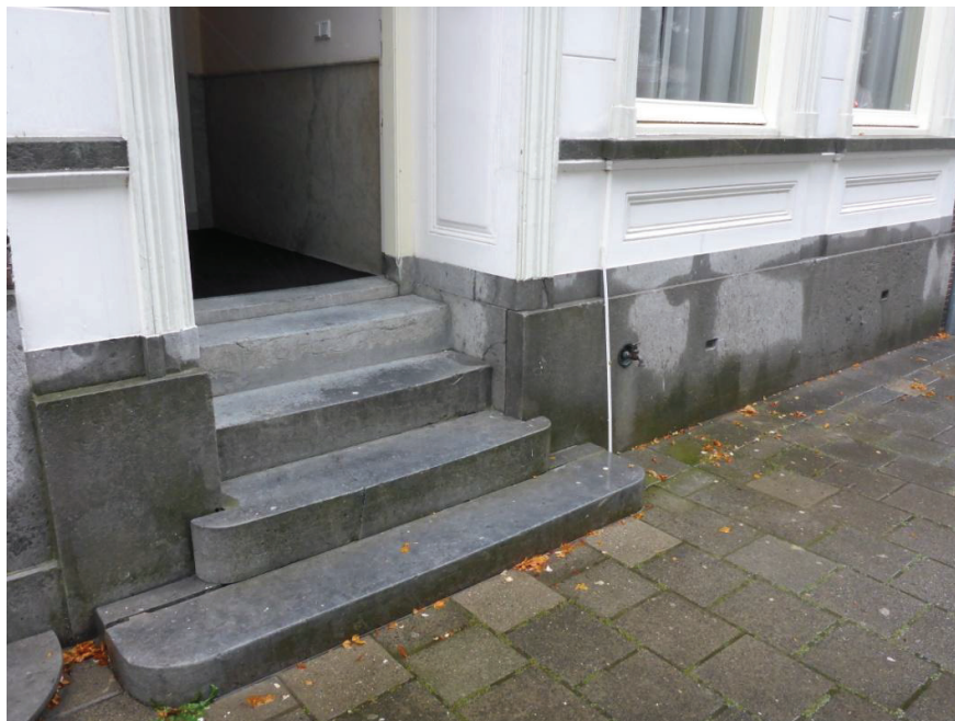
Detailfoto 2: afwerking van de voorgevel met twee ventilatieopeningen naar de kelder
