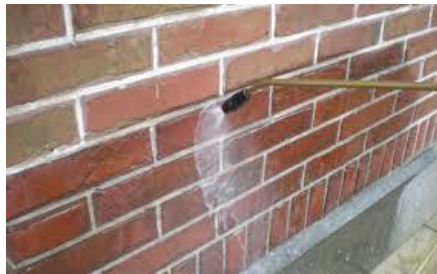
hydrofoberen van metselwerk
